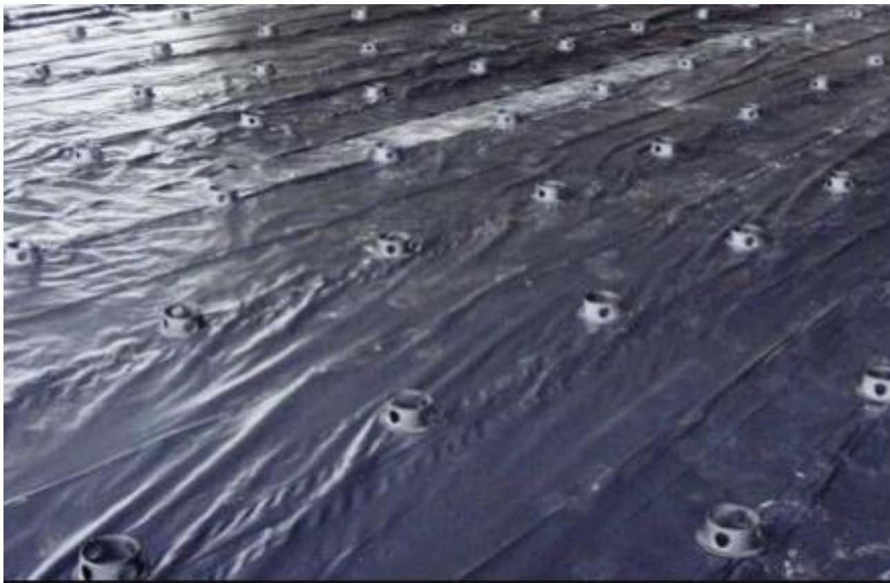
Figura 13: Impermeabilização com lona preta e espaçadores de concreto
